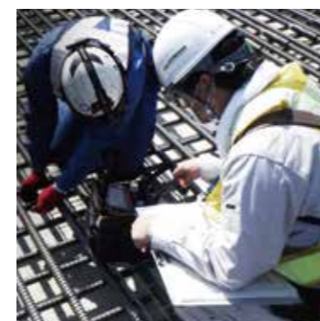
鉄筋組立作業(ガス圧接)
