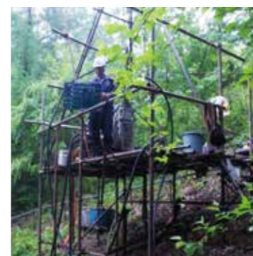
ボーリング掘進作業
