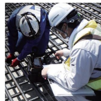
鉄筋組立作業(ガス圧接)
