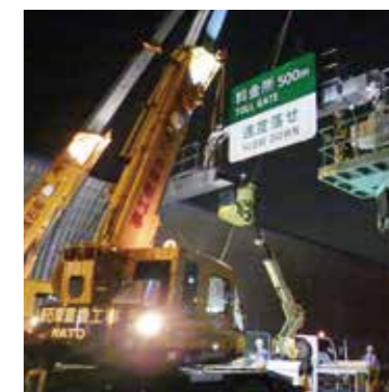
標識設置工事
