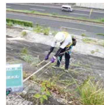
切土のり面調査
