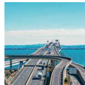
東京湾アクアライン橋梁
