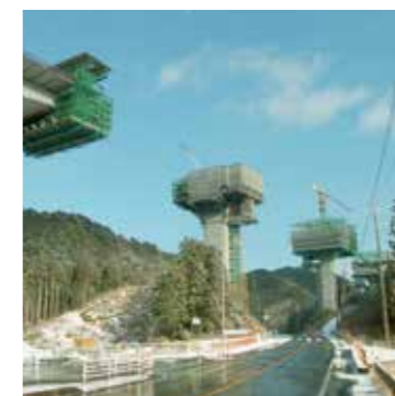
橋梁上部工事
