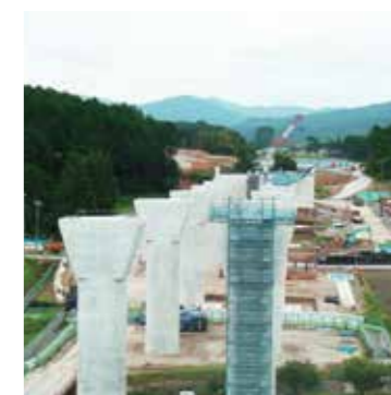
橋梁下部工事
